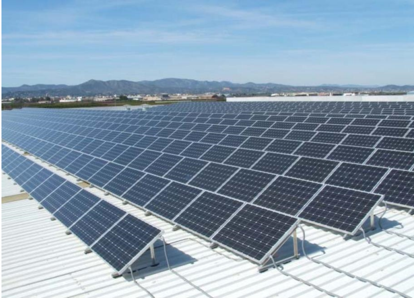
Energía solar fotovoltaica
